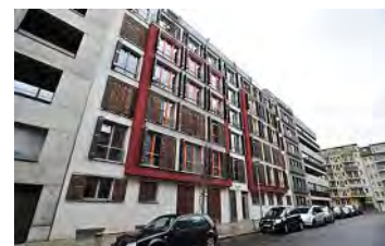
Zum Schutz Faltschiebeläden aus Holz sichern die Fenster
